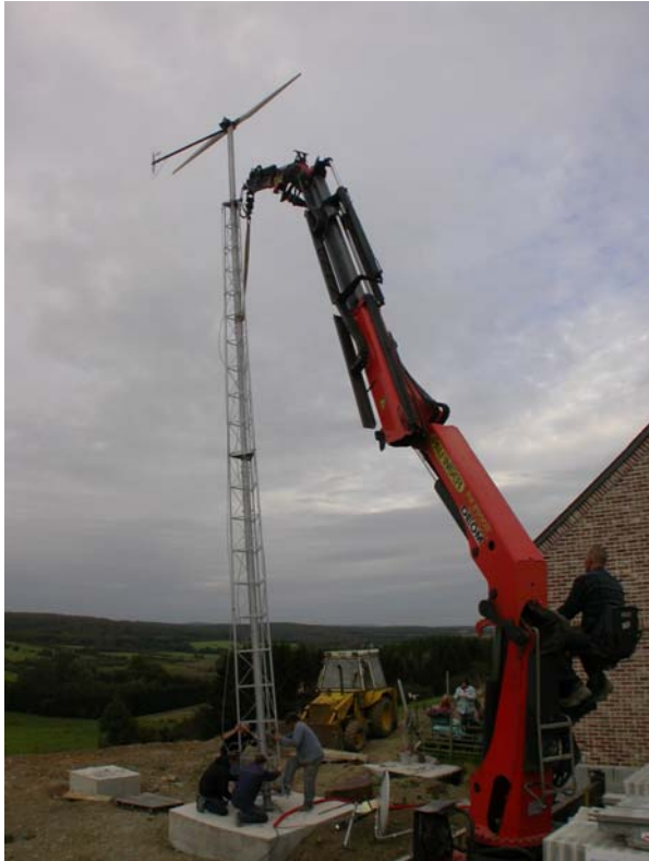
Fixation au socle de béton.
