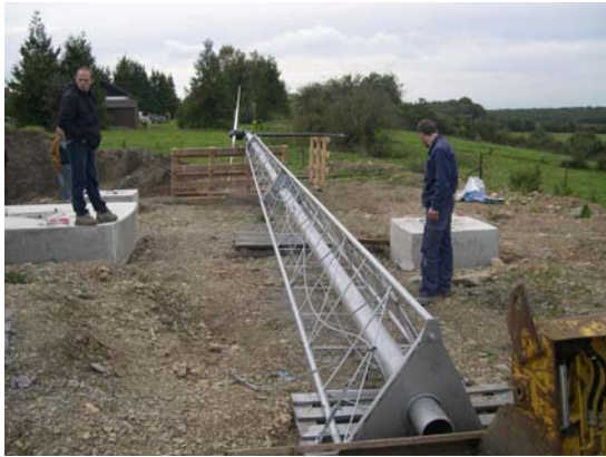
Mât à terre avec éolienne installée, les préparatifs...
