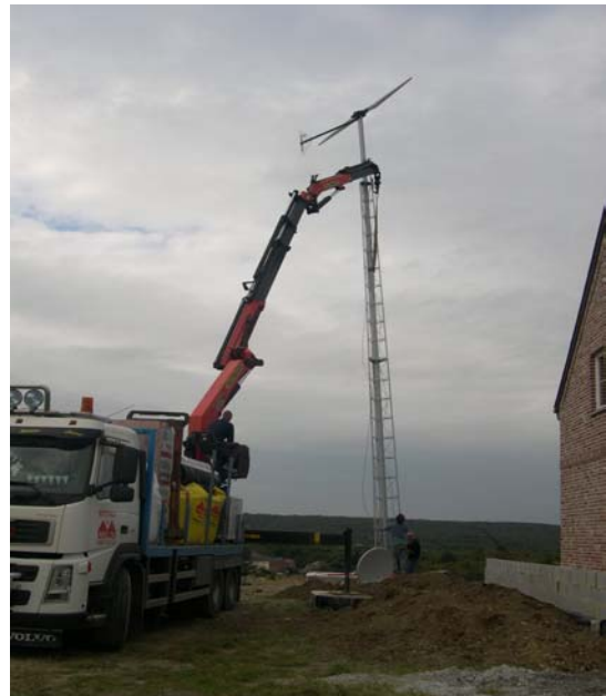
Elévation de l'ensemble à l'aide de la grue.
